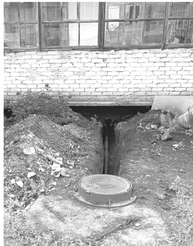
На фото: работы по реконструкции канализационных сетей
